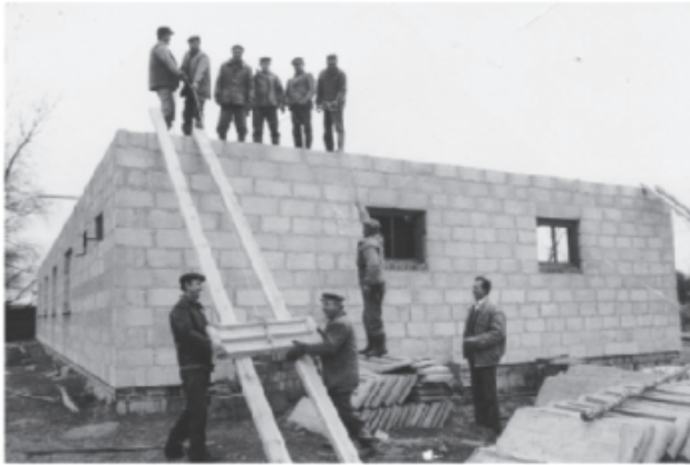
Budowa remizo-świetlicy w Andrzejowie - 1988 Z archiwum autora
