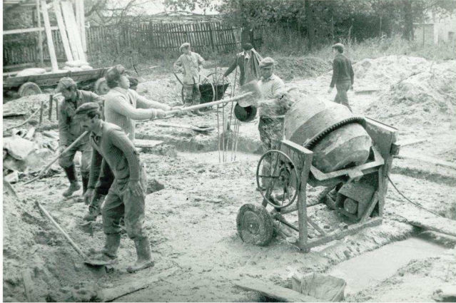
Mieszkańcy Wereszczyna w trakcie prac społecznych przy budowie remizy strażackiej - 1984
